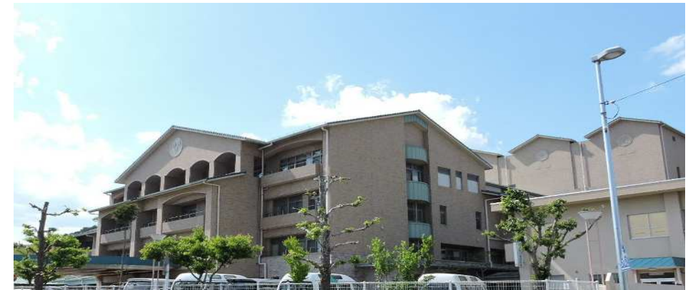
▲ 長生園施設全景
