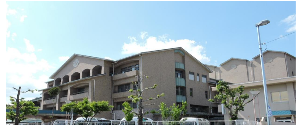
▲ 長生園施設全景
